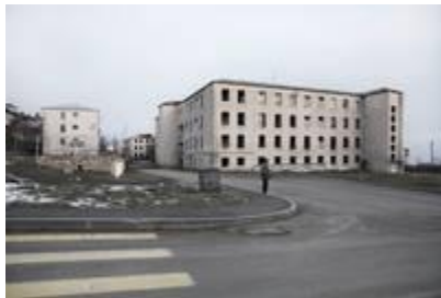
Zerstörter Wohnblock in Schuscha
